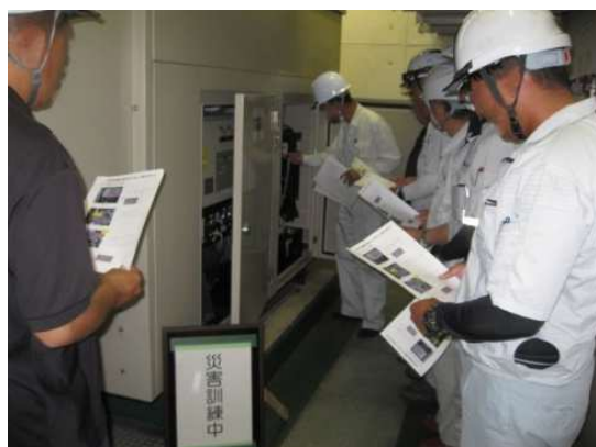
市川農業集落排水処理施設
